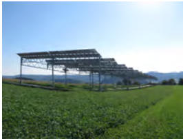
Agrophotovoltaik-Pilotanlage in Heggelbach am Bodensee. © Fraunhofer ISE.
